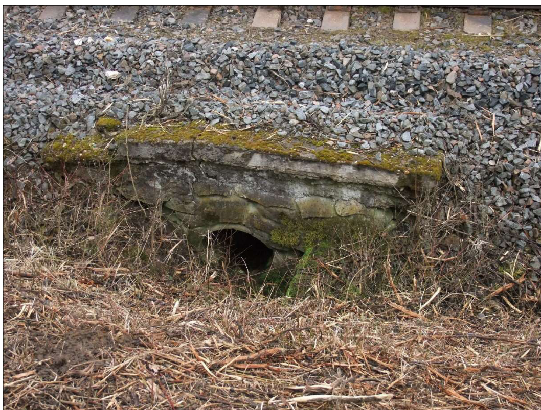
Obr. 14: Propustek v drážním km 9,215 určený k rekonstrukci
